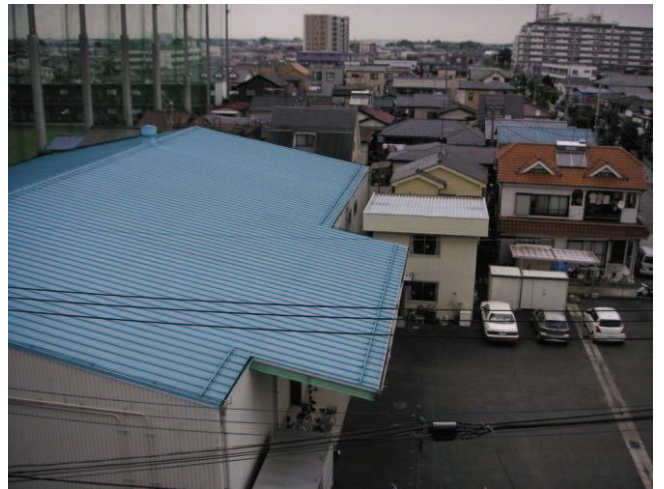
屋根塗装箇所
